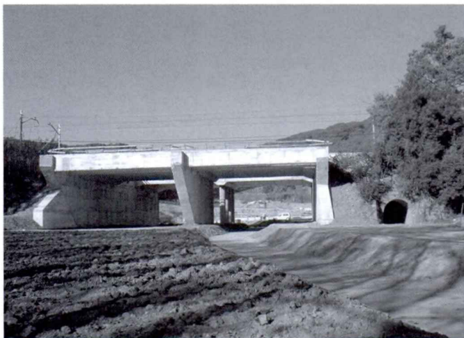
FIGURA 7. Recuperació del connector del torrent de Palomeres. El nou traçat de la LAV ha incorporat, com a mesura compensatòria del projecte, la construcció d'un pas de fauna en el terraplè de la línia de ferrocarril convencional (a la dreta s'aprecien encara el terraplè i la petita estructura de drenatge que interceptaven el curs fluvial). Falta encara donar continuïtat a la intervenció fins a connectar el torrent amb l'eix de la Tordera (foto: Carme Rosell).
